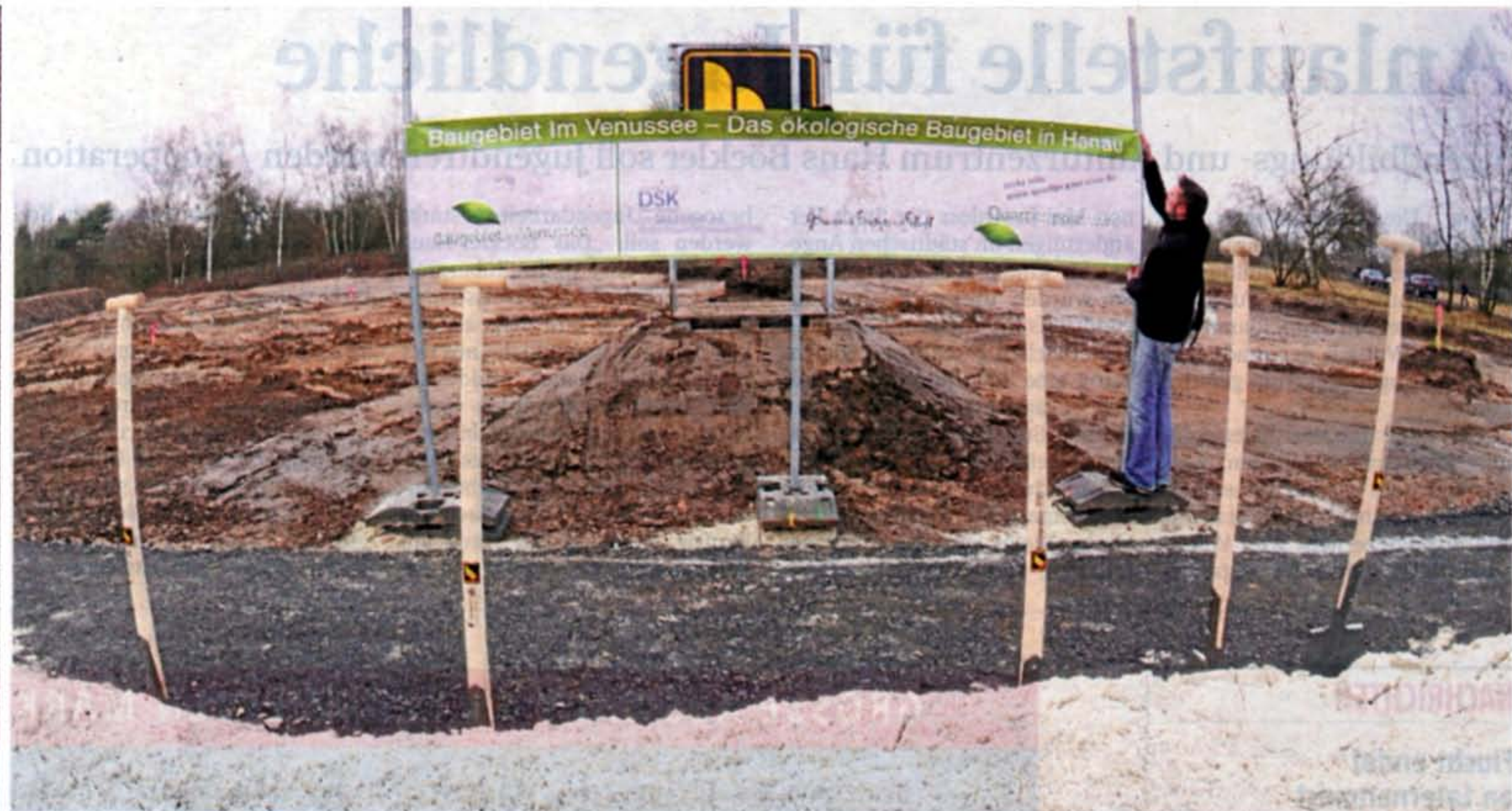
Spatenstich für das Neubaugebiet Im Venussee. Vor Baubeginn wird das Gelände mit viel Erde aufgeschüttet.
