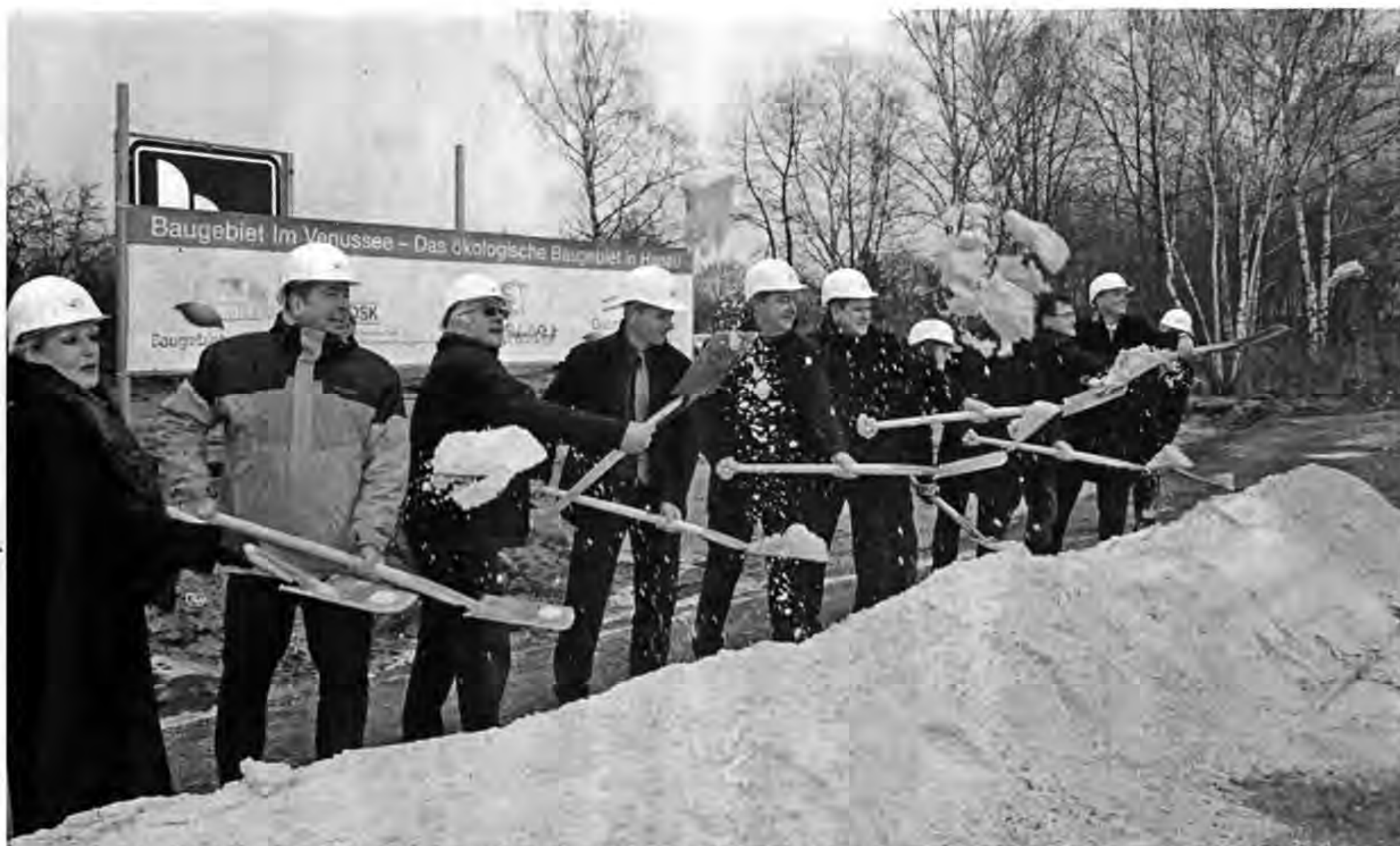
„An die Schippen, fertig, los“: Gestern setzten Vertreter von Stadt und Projektentwicklung den ersten Spatenstich für das ökologische Vorzeigebaugebiet „Im Venussee“. Fotos: Fexon
