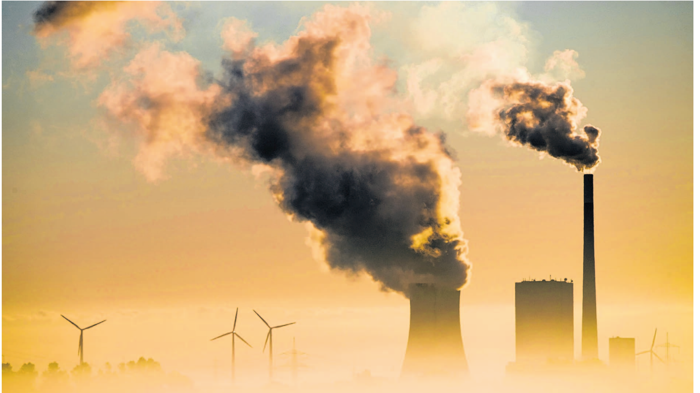
Das Kohlekraftwerk Mehrum und Windräder in Hohenhameln (Niedersachsen). Allein die Sonne liefert mehr Energie, als Menschen auf der Erde derzeit verbrauchen, sagt Energieexperte Franz Alt. Er mahnt zu einer weltweiten Energiewende.
